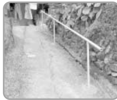
立派な手すりが出来ました。
